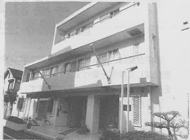
鉄筋コンクリート地上3階地下1階建 平成5年10月完成
